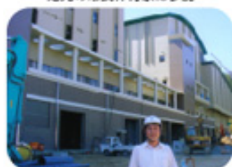
工事中の国崎クリーンセンターを視察
