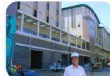
工事中の国崎クリーンセンターを視察。どんな課題でも現場に出向き調査することを心がけています。
